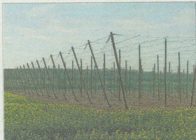
Výstavba nové konstrukce
