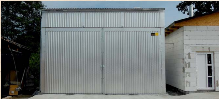
Obr. 3 – Tepelné ošetřování DOM probíhá v sušárnách dřeva
