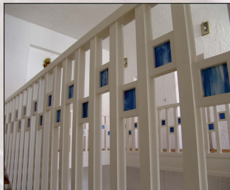
Zábradlí halového ochozu
