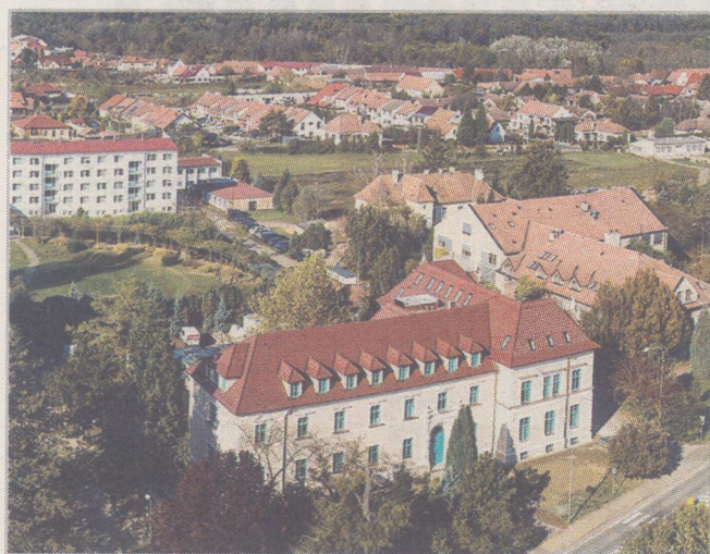
Rekonstruovaná budova Zahradnické fakulty
